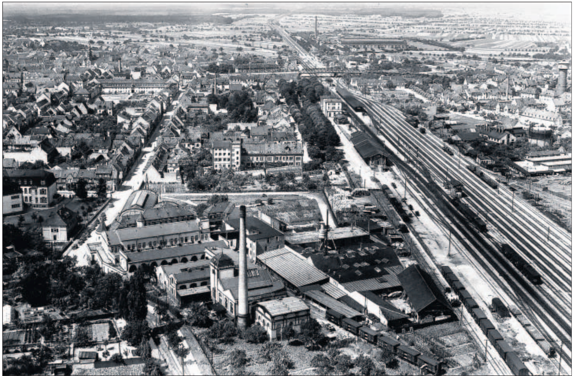
Ein Blick aus Richtung Süden auf die Stadt zeigt im Vordergrund das weitläufige Werksgelände der Konservenfabrik Bassermann. Deutlich sind auch rechts davon die Bahnlinie und links davon die Marstallstraße zu erkennen. Das Foto stammt etwa aus dem Jahre 1930.
